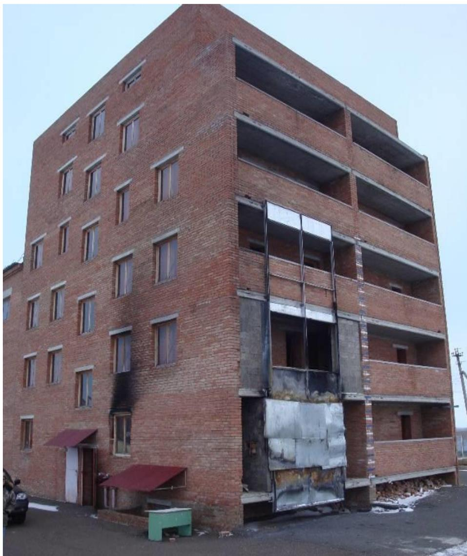
Рисунок 1 – Фасад здания после локального пожара на 1 этаже
