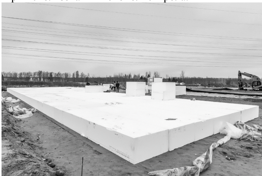
Рисунок 3. Применение пенополистирольных блоков в дорожном строительстве
