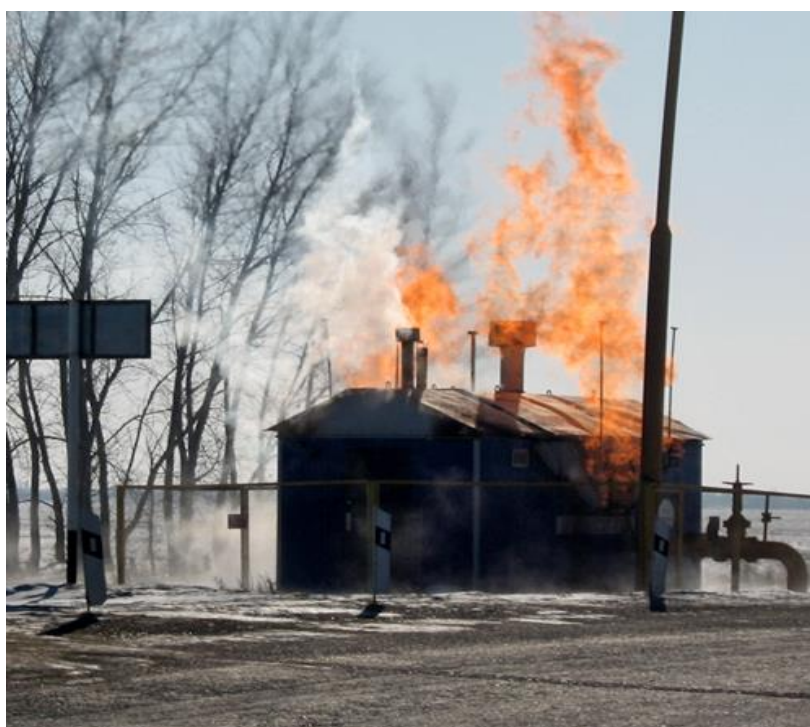
Рисунок 5 - Авария на газопроводе (Омская область, январь 2017г.)
