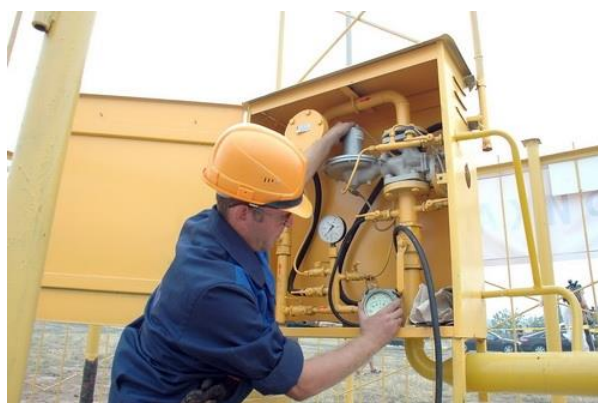
Рисунок 4 – Осмотр шкафного регуляторного пункта (ШРП)
