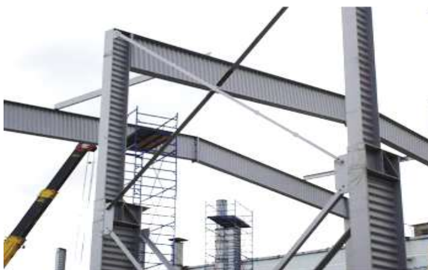
Рисунок 4 – Поперечные рамы каркаса с ригелем и колоннами из гофро-балок с поперечным гофрированием стенки
