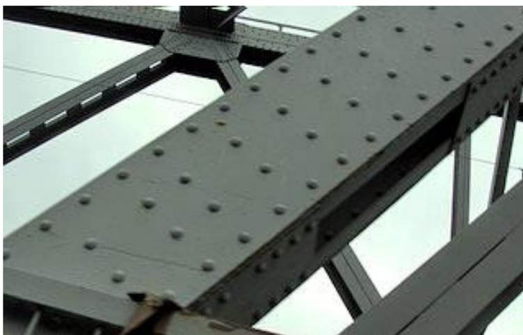
Рисунок 1.1 – Заклепочные соединения
