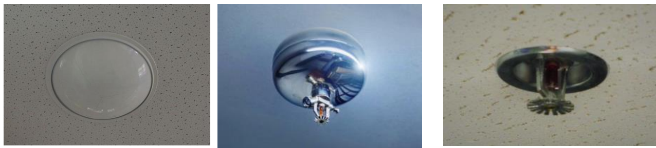
Рисунок 65 – Оросители с зеркальным отражателем или с устройством углубленного монтажа
