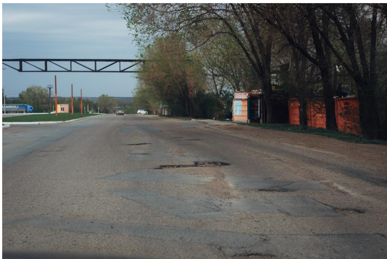
11 - Участок автомобильной дороги по ул. Технической, 23
