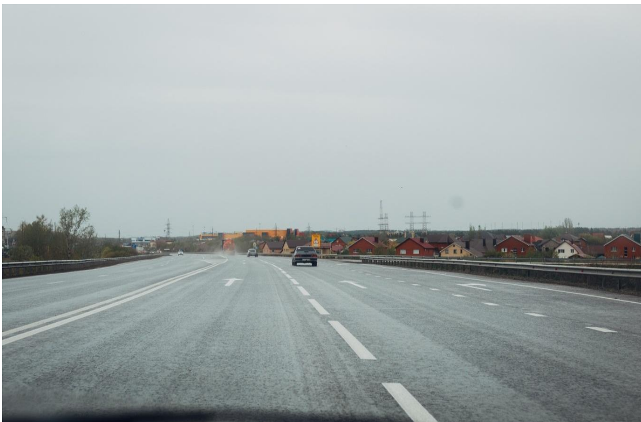
Рисунок 24 - Участок автомобильной дороги около пос. «Солнечный»
