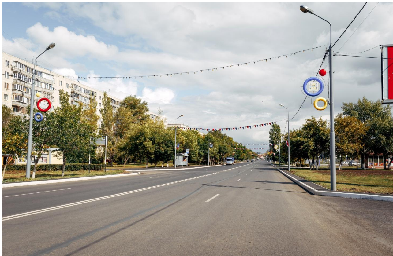
Рисунок 42 - Участок дороги по ул. Новой
