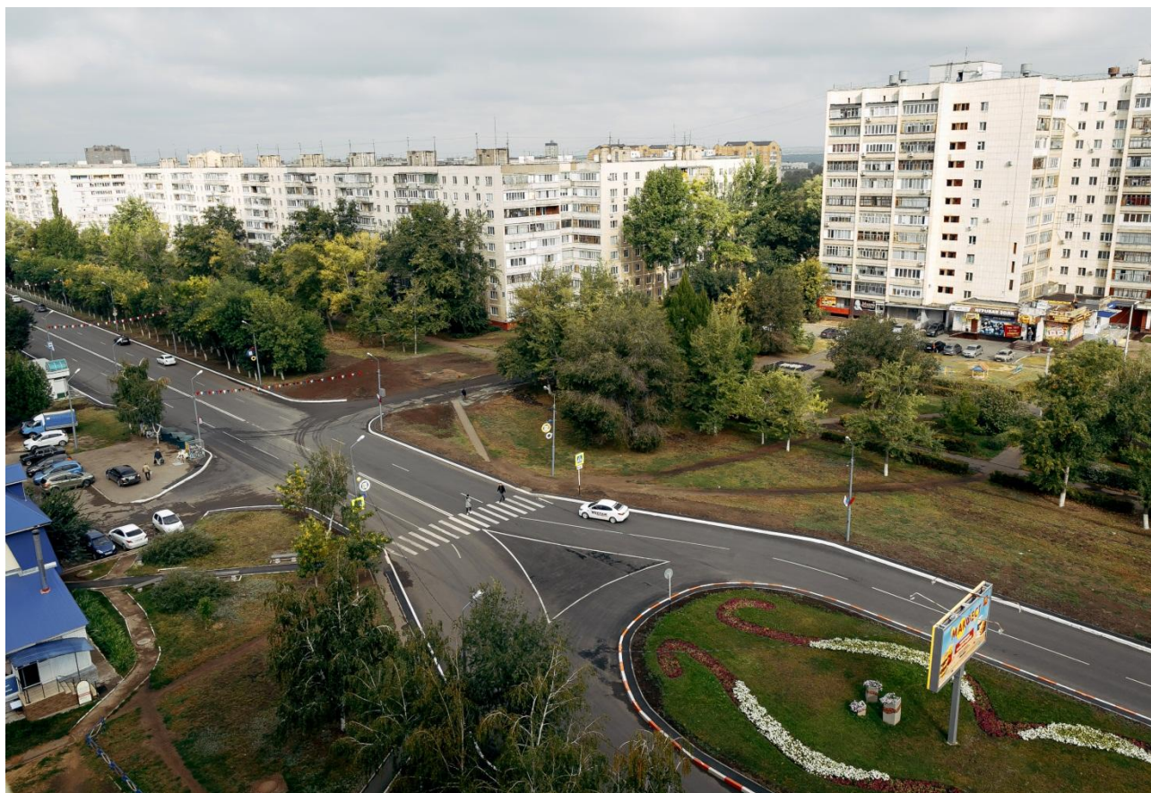
Рисунок 38 - Участок дороги по ул. Новой
