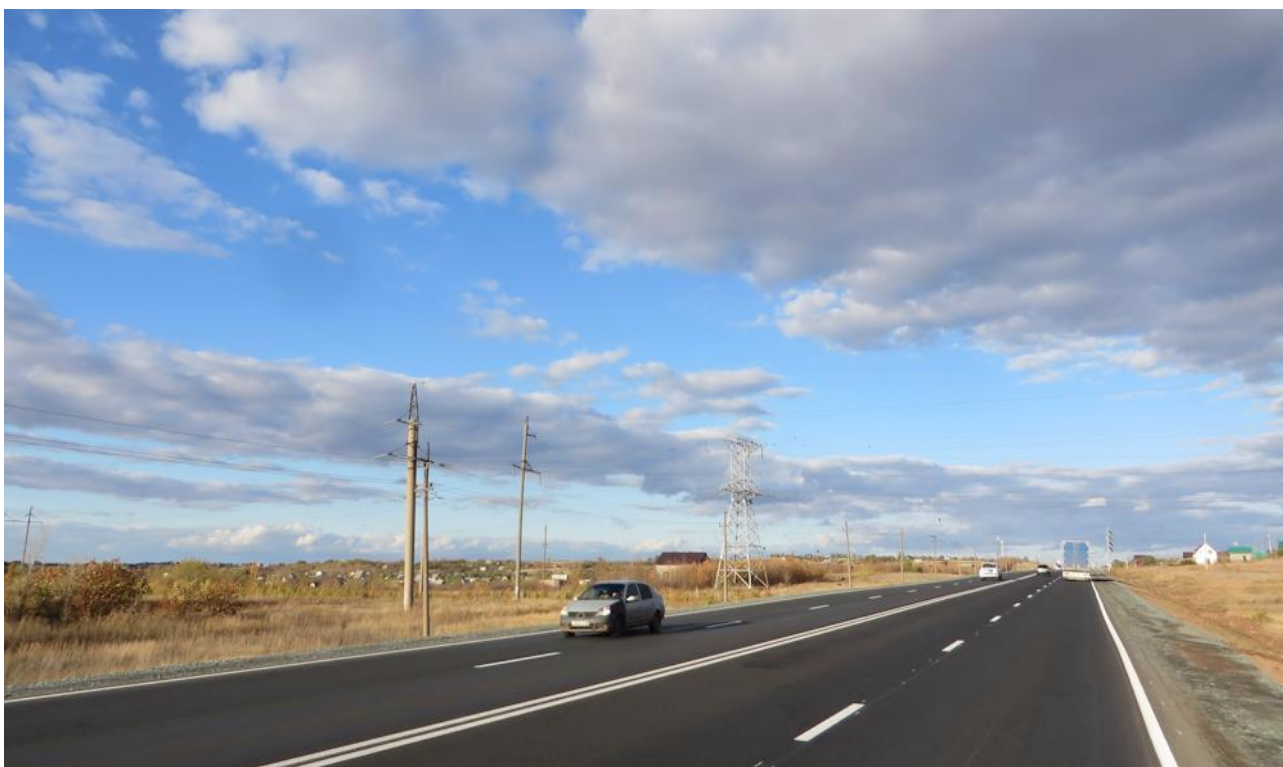
Рисунок 19 – Отремонтированный участок дороги Оренбург – Орск – Шильда
