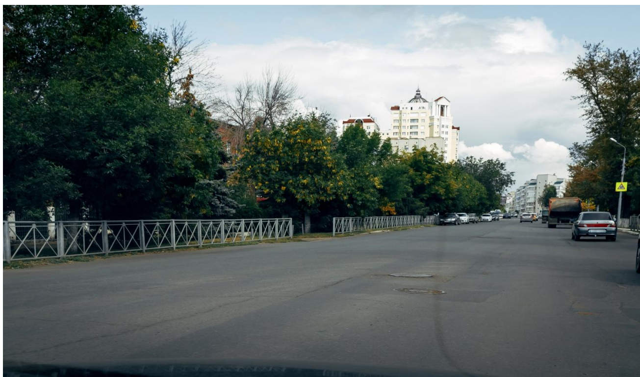
Рисунок 60–Участок дороги по ул. Челюскинцев
