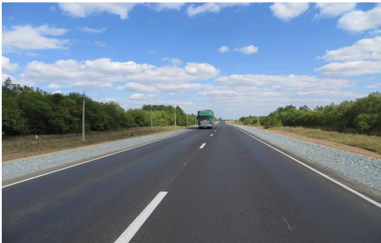
Рисунок 18 – Отремонтированный участок дороги Казань – Оренбург
