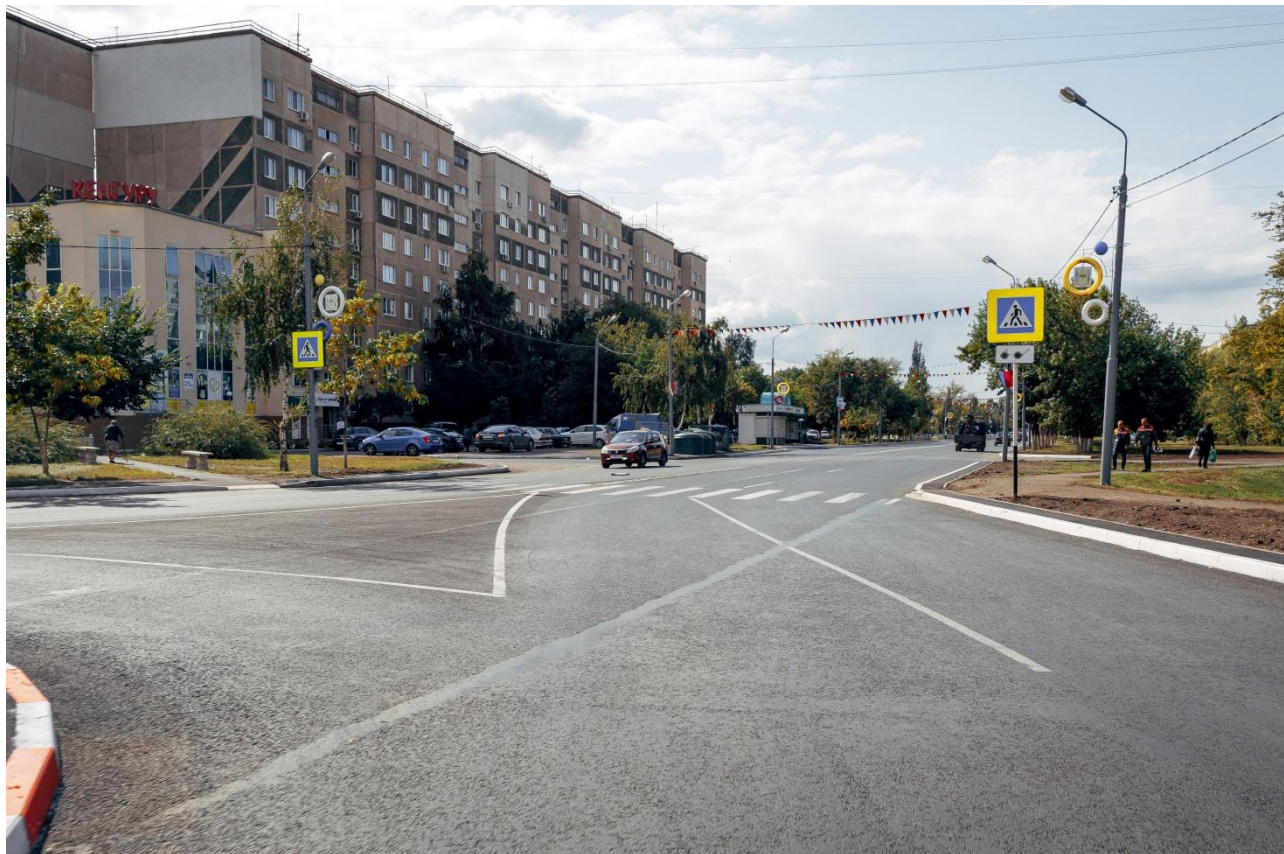
Рисунок 41 - Участок дороги по ул. Новой
