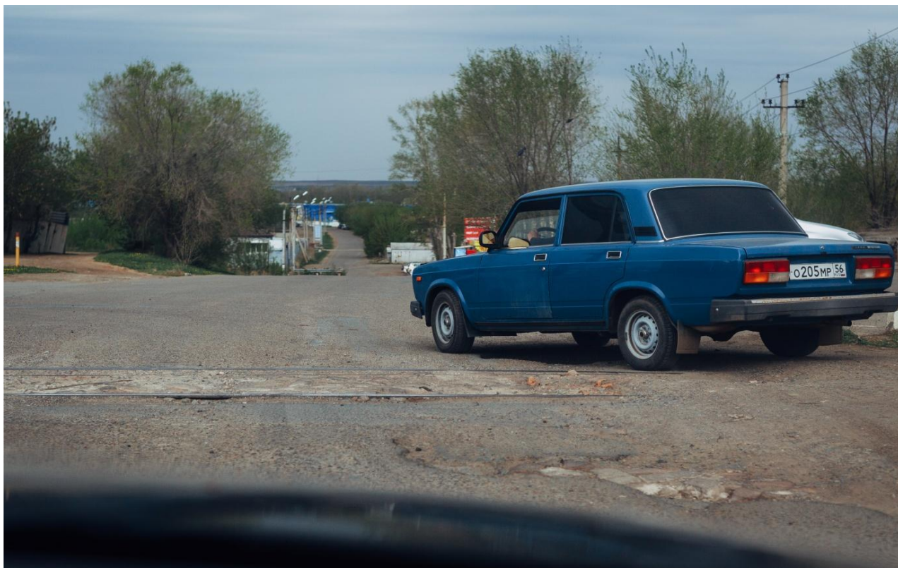
Рисунок 35 - Участок автомобильной дороги по ул. Технической, 23
