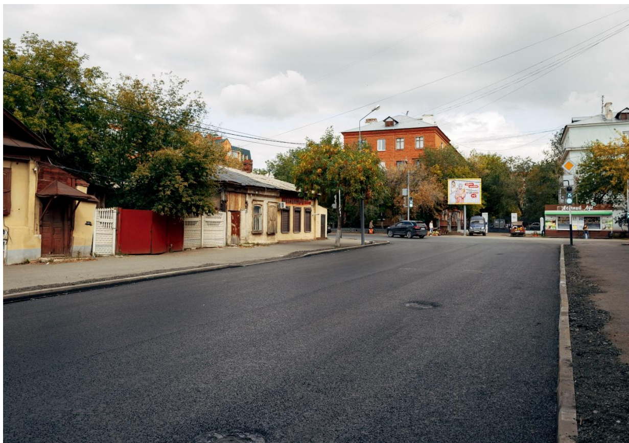
Рисунок 53—Участок дороги по ул. М. Горького
