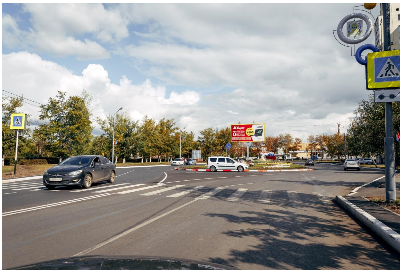
Рисунок 39 - Участок дороги по ул. Новой
