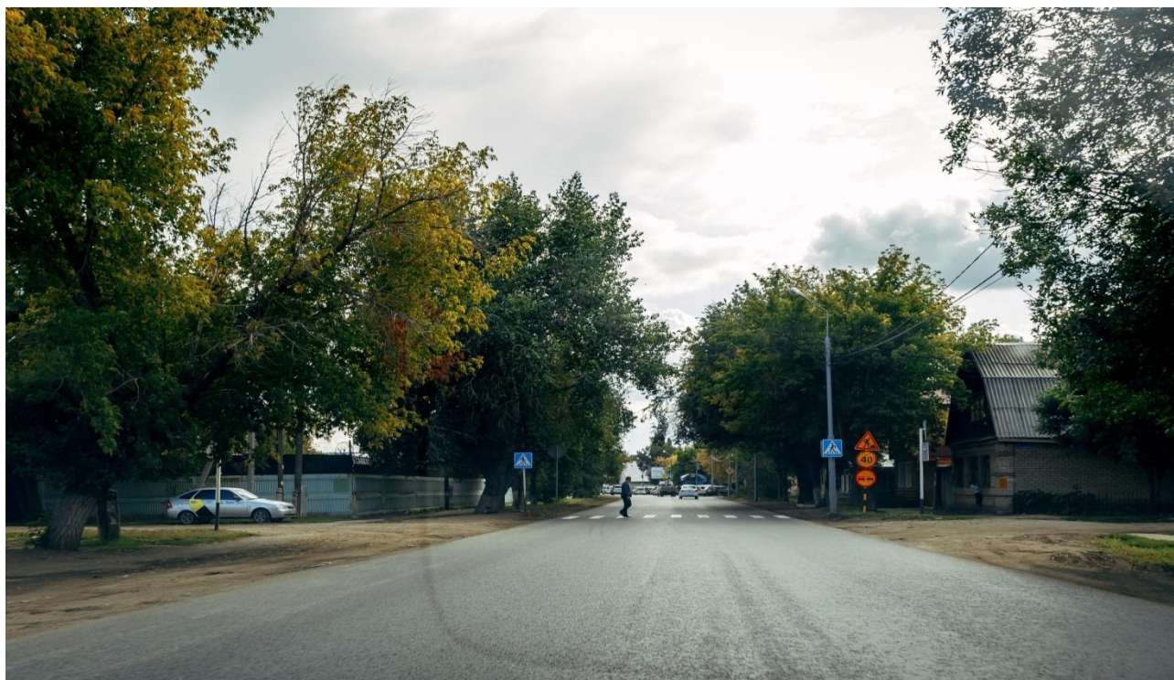
Рисунок 59 – Участок дороги по ул. Пролетарской
