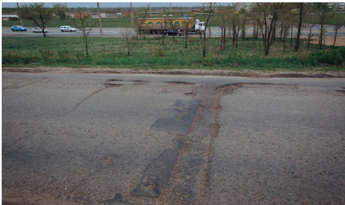
9 - Участок автомобильной дороги по развязке Нежинского и Загородного шоссе
