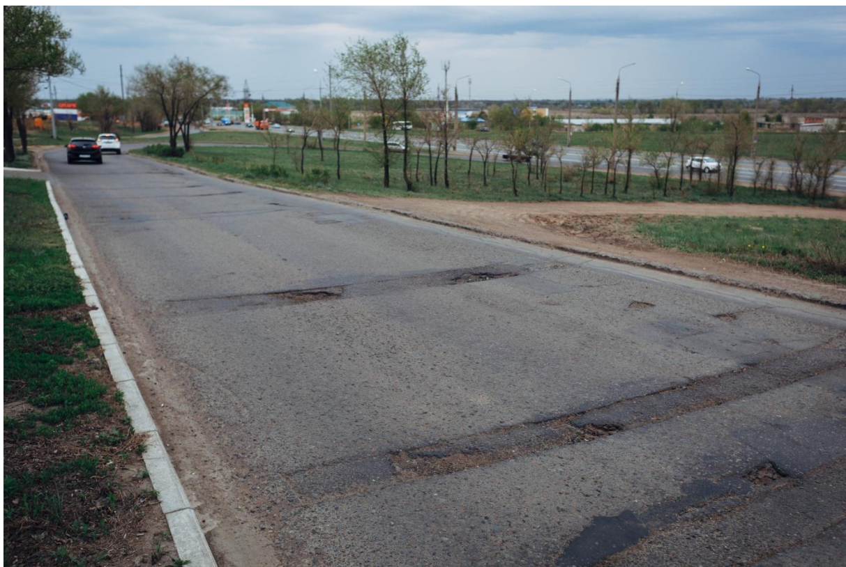
10 - Участок автомобильной дороги по развязке Нежинского и Загородного шоссе
