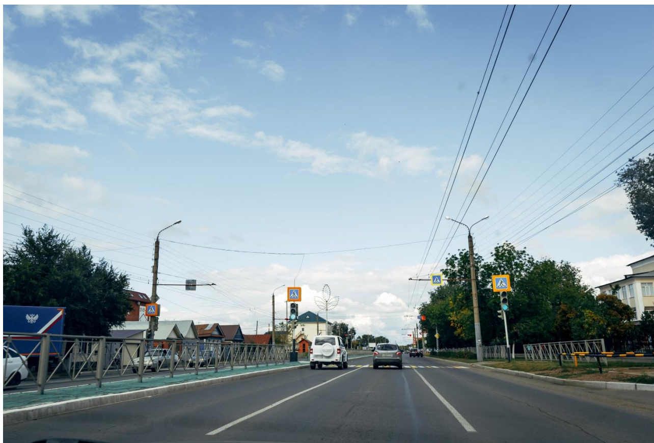
Рисунок 45 - Участок дороги по ул. Терешковой
