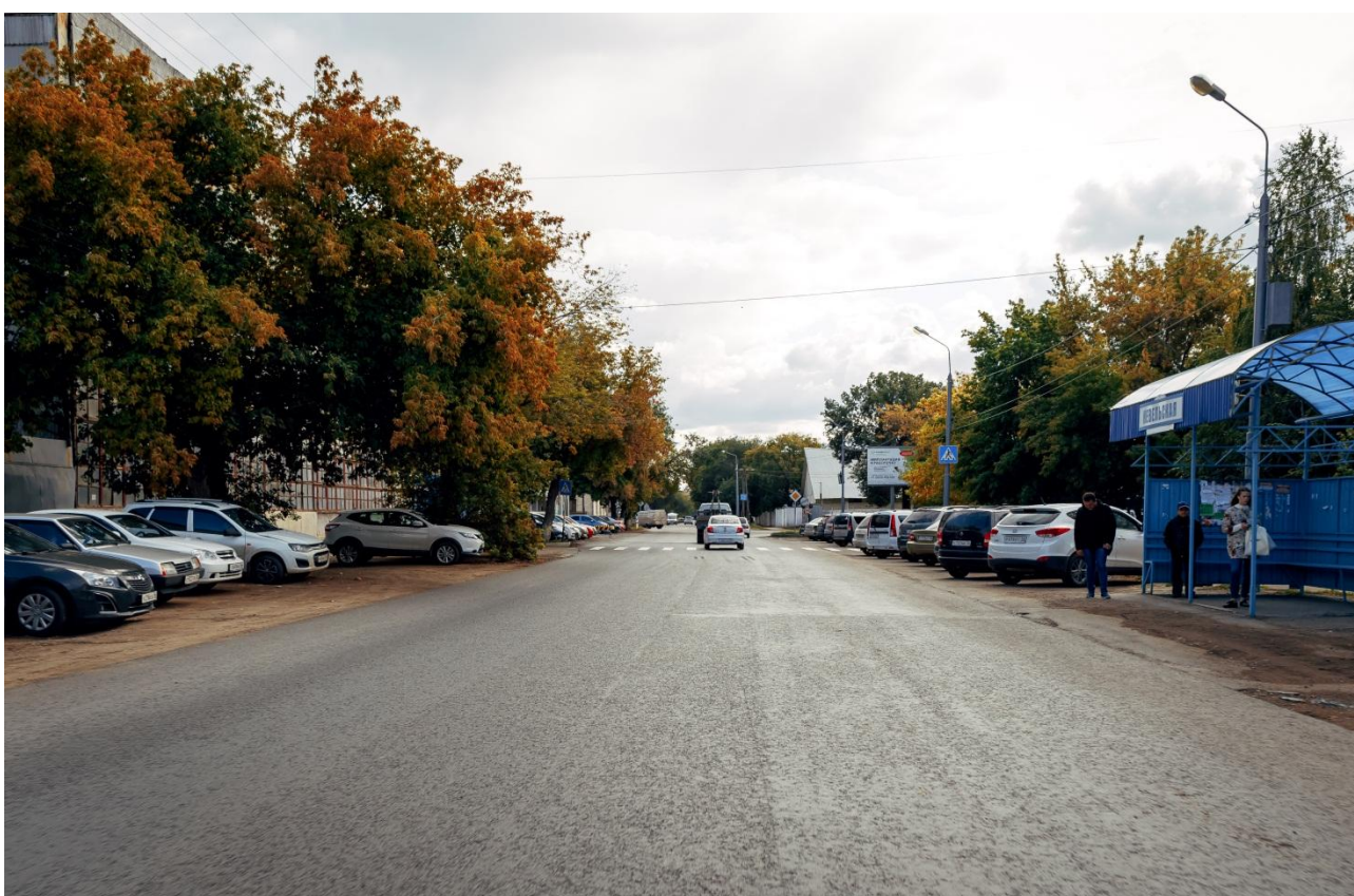
Рисунок 58 – Участок дороги по ул. Пролетарской
