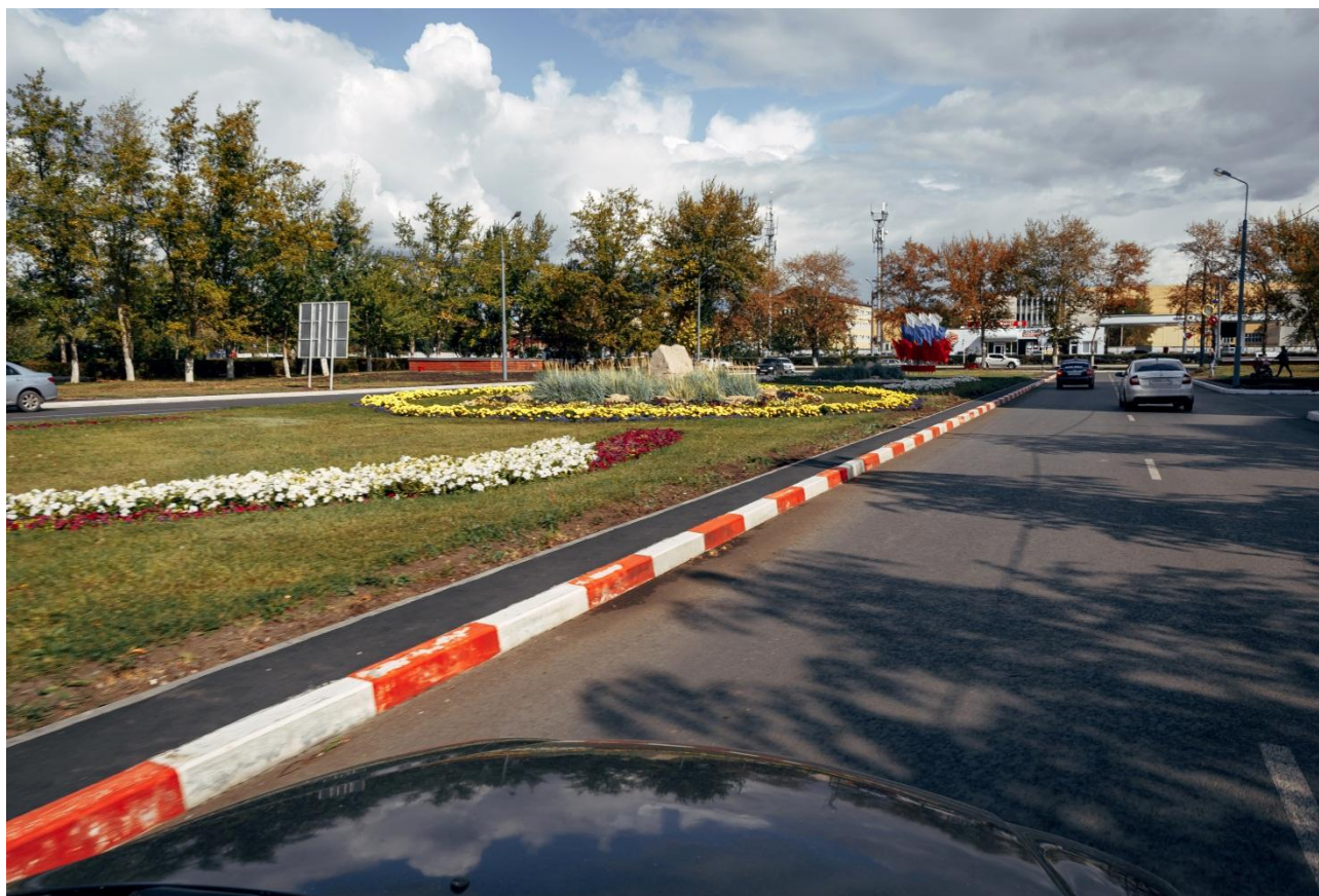
Рисунок 40 - Участок дороги по ул. Новой
