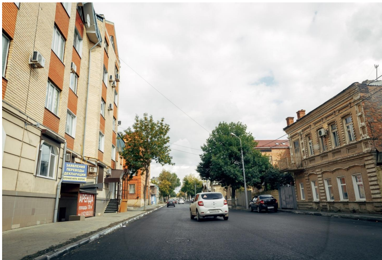
Рисунок 49—Участок дороги по ул. М. Горького
