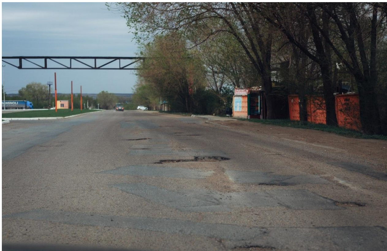
Рисунок 30 - Участок автомобильной дороги по ул. Технической, 23
