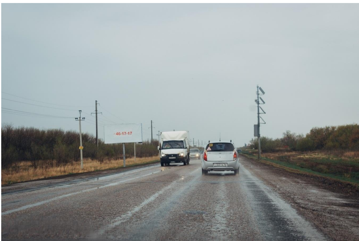
13 - Участок автомобильной дороги по Беляевскому шоссе (около Ива- новских садов)
