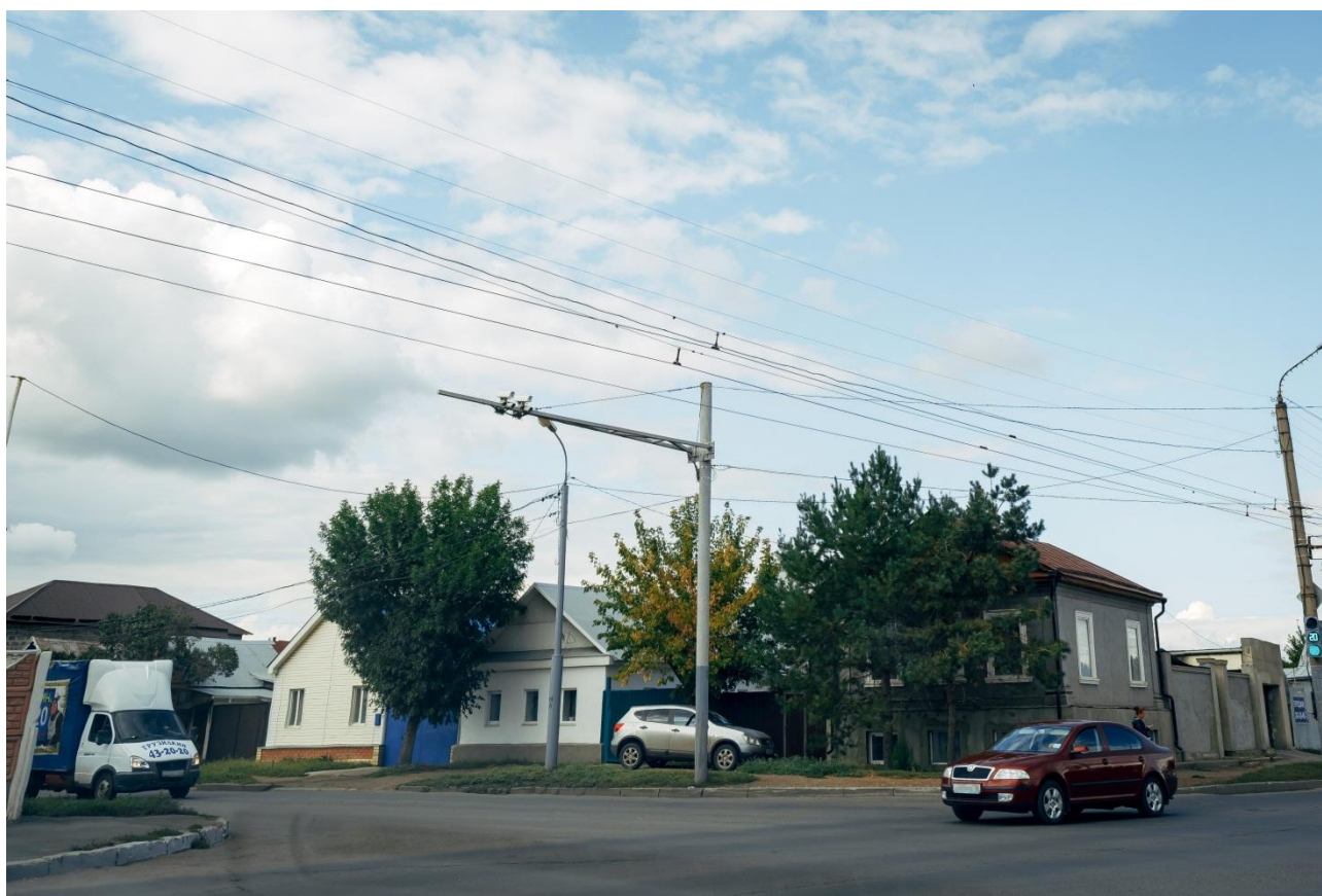
Рисунок 56 – Участок дороги по ул. Терешковой
