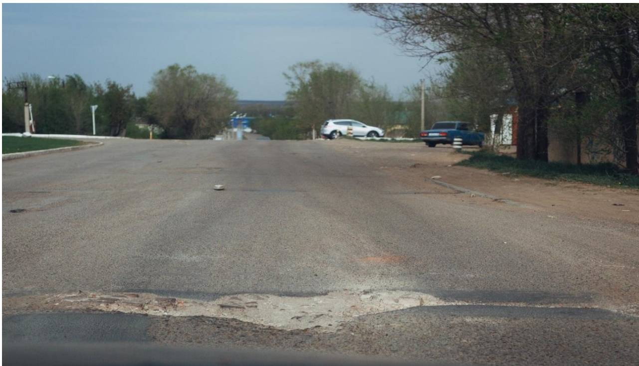
Рисунок 26 – Участок автомобильной дороги по ул. Технической
