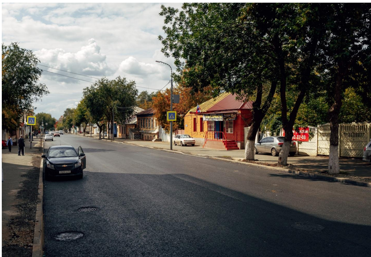
Рисунок 54— Участок дороги по ул. М. Горького
