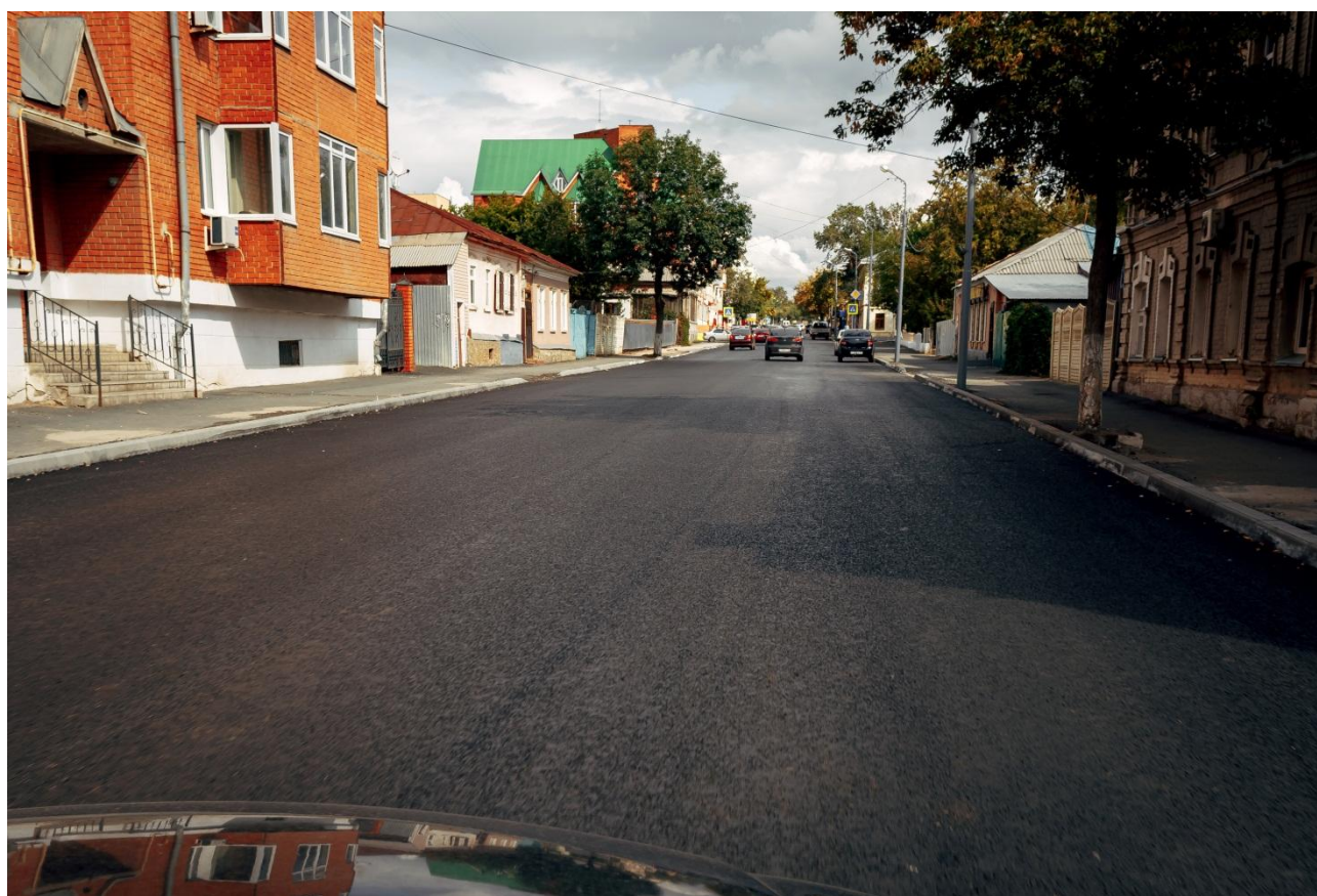
Рисунок 50—Участок дороги по ул. М. Горького
