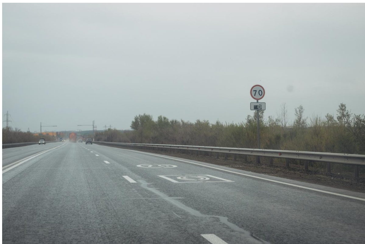
17 - Участок автомобильной дороги около пос. «Солнечный»
