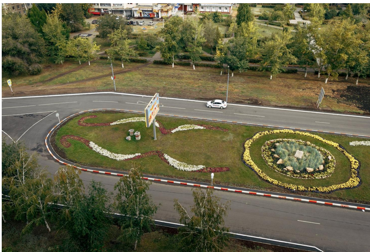
Рисунок 37 - Участок дороги по ул. Новой
