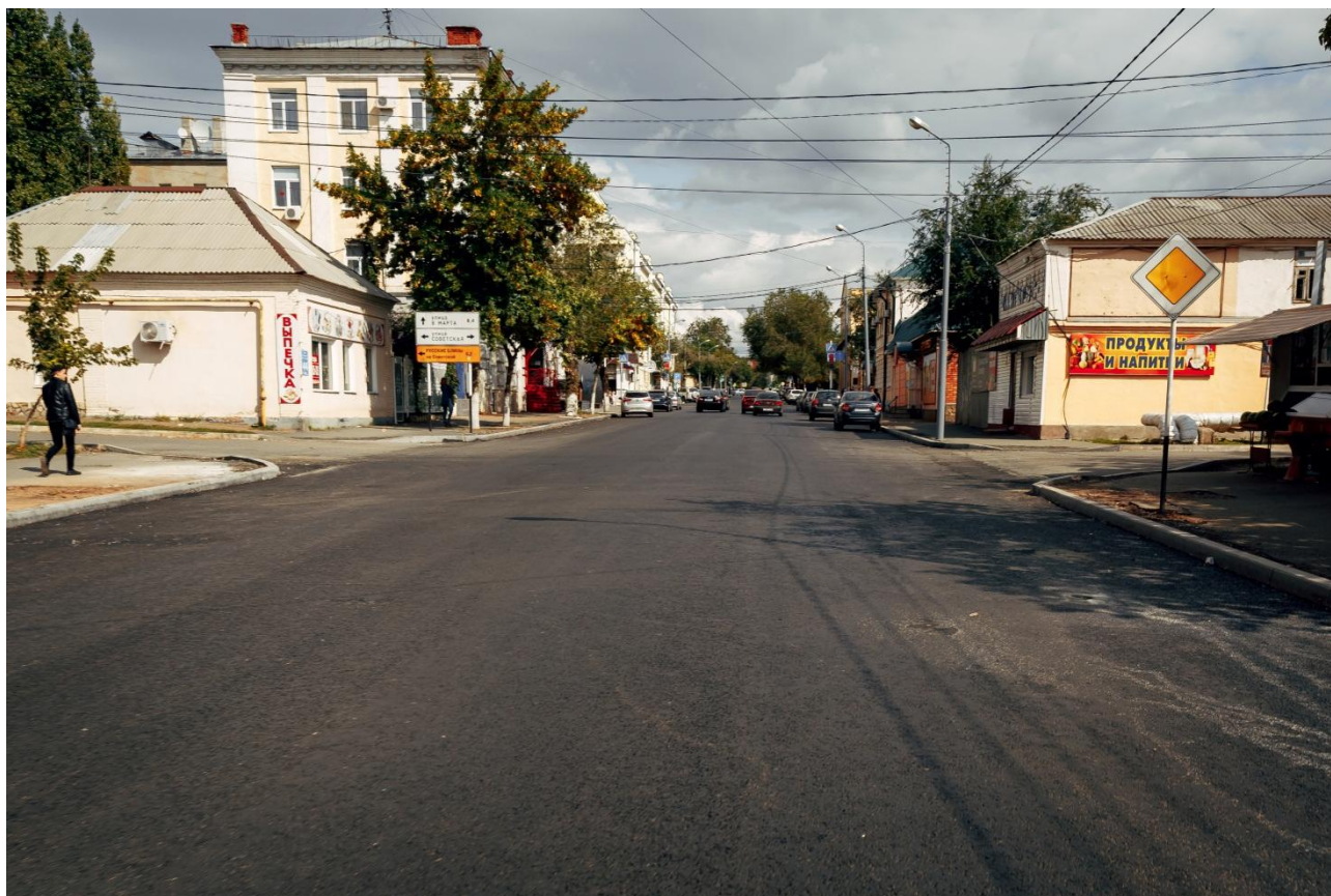
Рисунок 51—Участок дороги по ул. М. Горького
