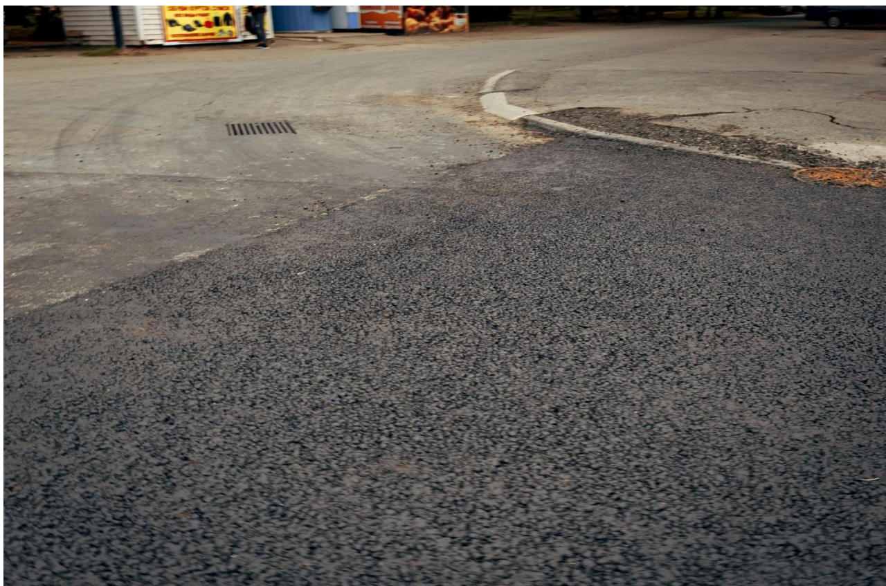
Рисунок 55—Участок дороги по ул. М. Горького
