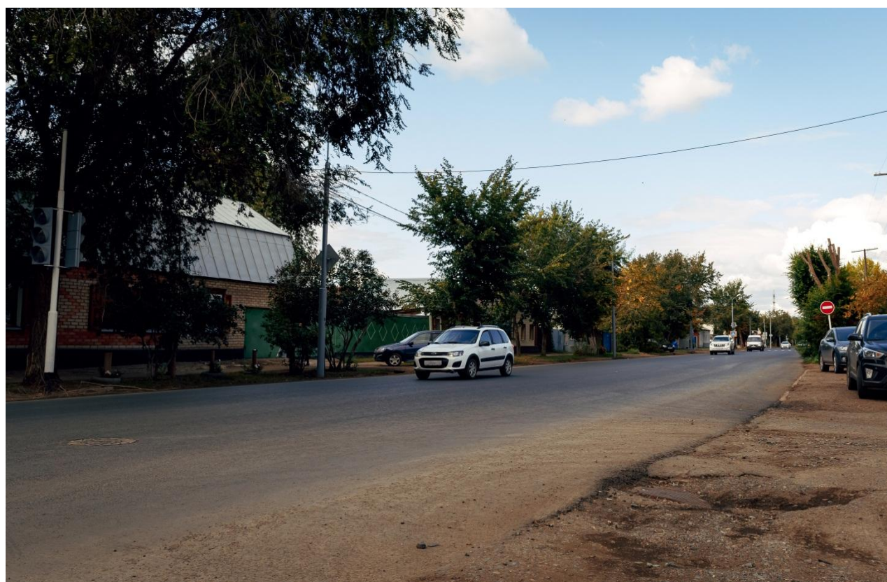
Рисунок 62—Участок дороги по ул. Пролетарской
