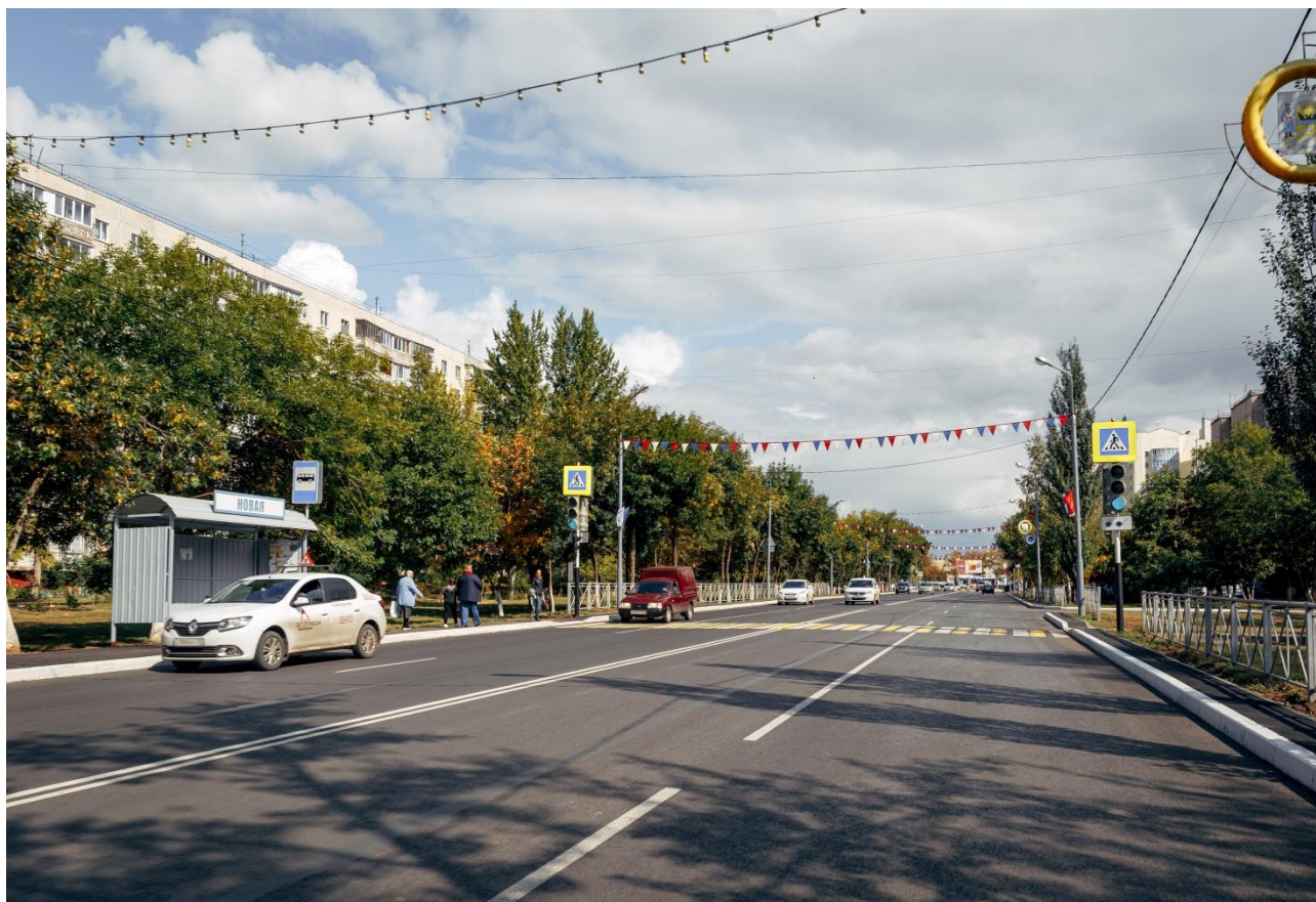
Рисунок 44 - Участок дороги по ул. Новой
