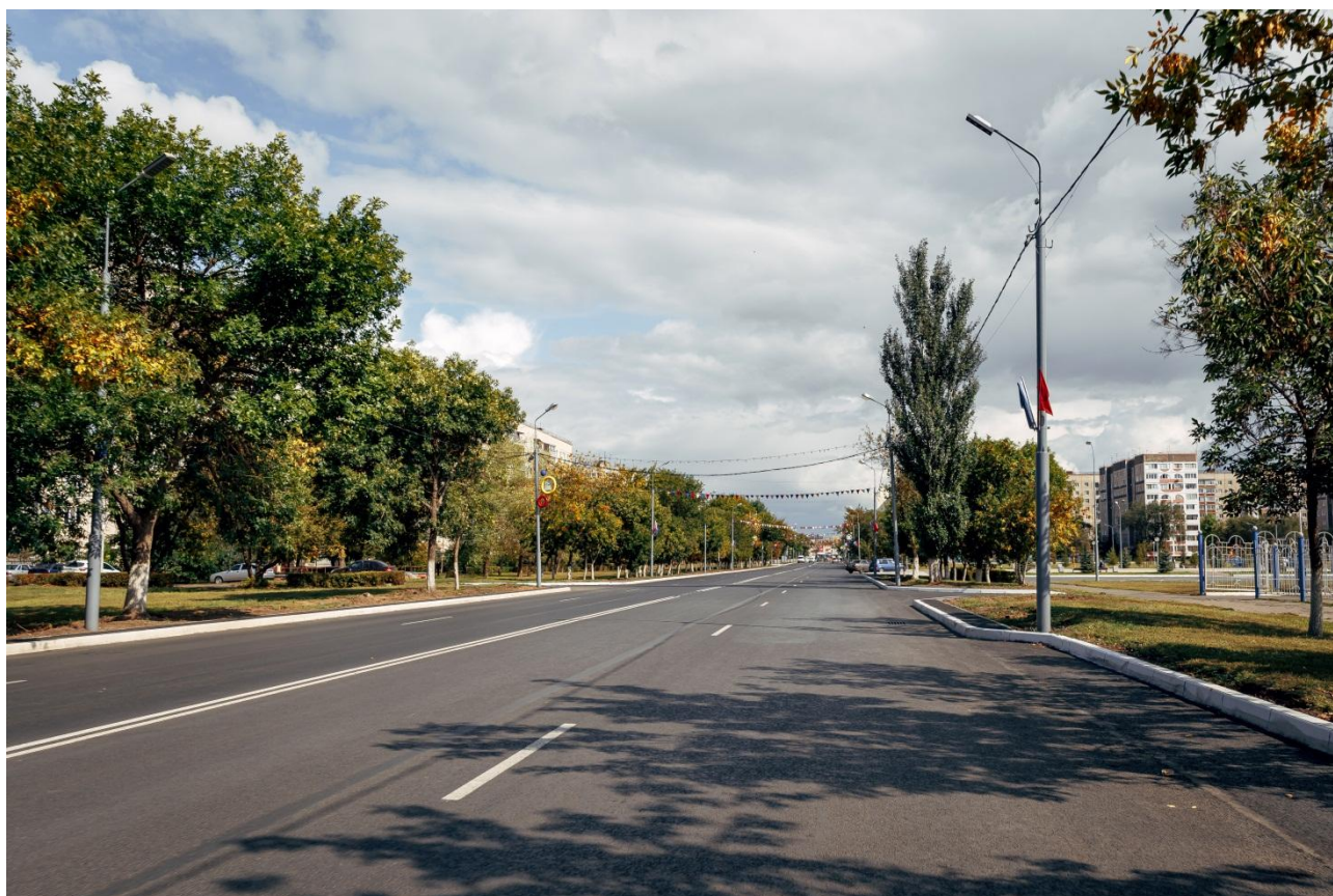
Рисунок 43 - Участок дороги по ул. Новой
