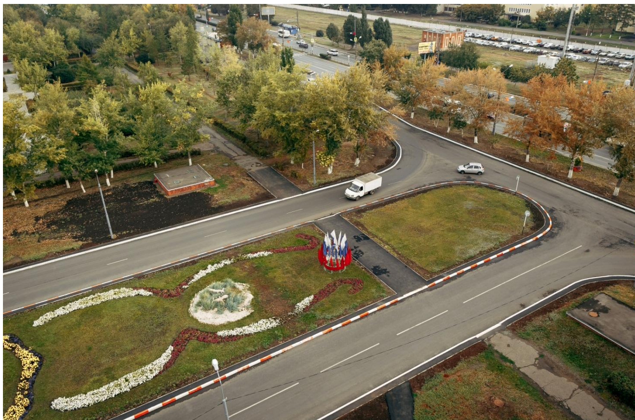
Рисунок 36 - Участок дороги по ул. Новой
