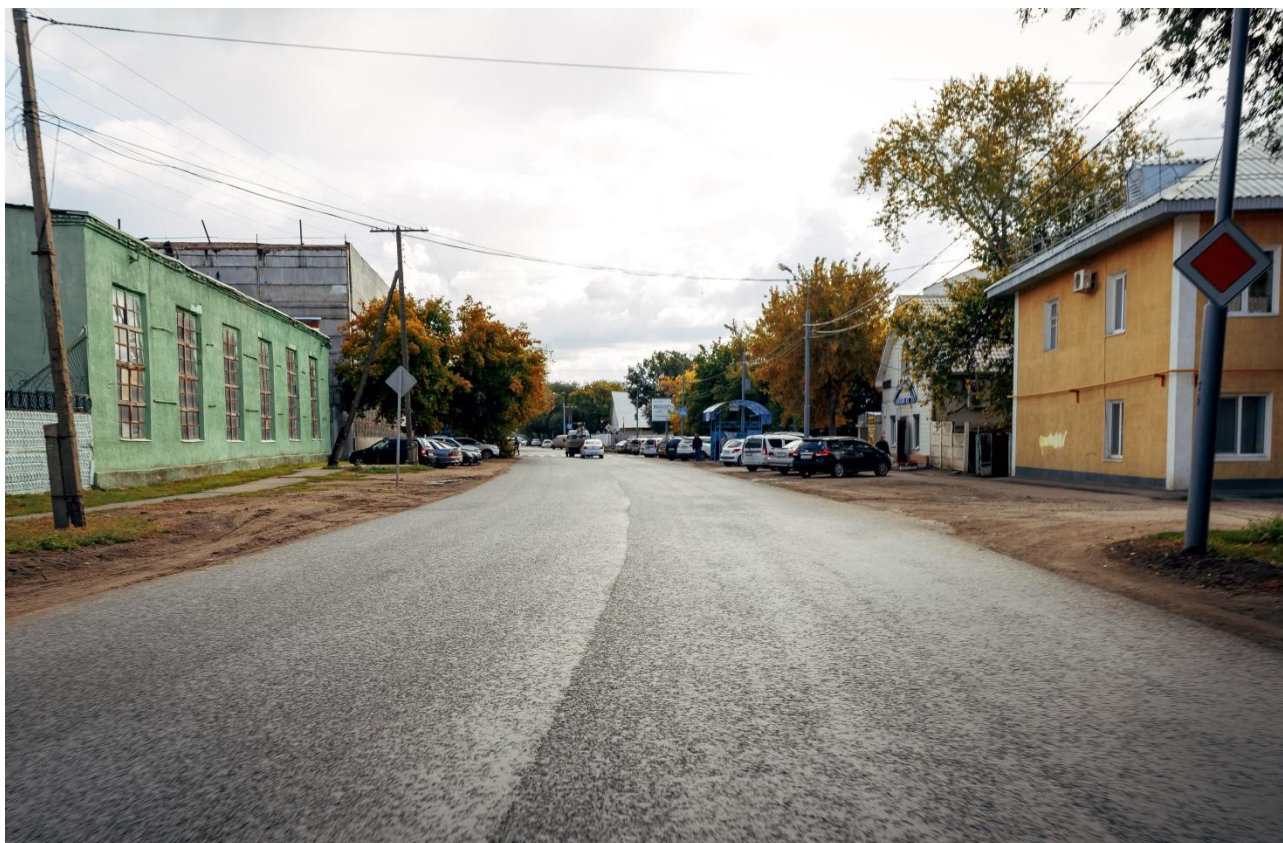
Рисунок 57 – Участок дороги по ул. Пролетарской
