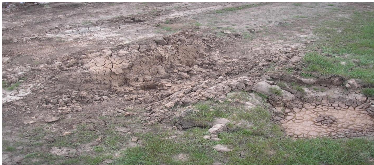
Рисунок Д.1 – Фото колеи от грузовых машин на месте прокладки ВОЛС АСУ ТП
