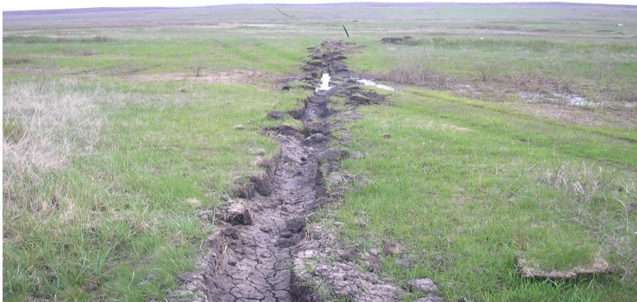
Рисунок Д.2 – Фото траншеи по завершении прокладки ВОЛС АСУ ТП
