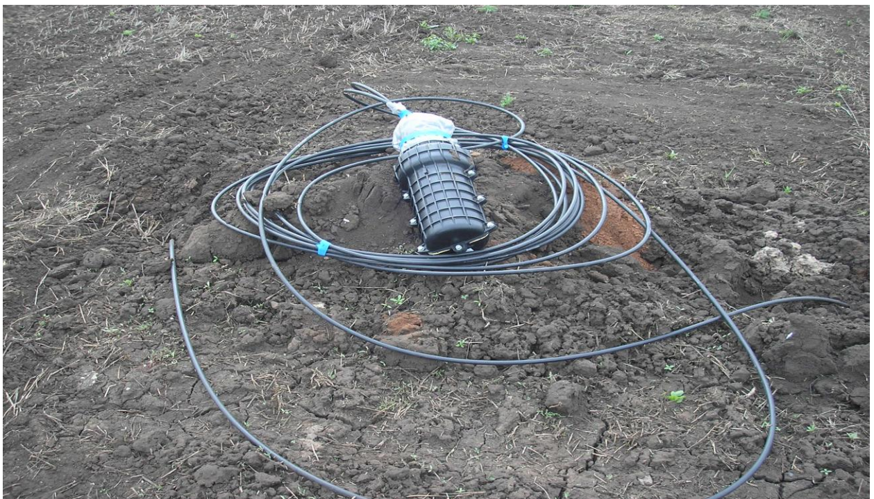
Рисунок Д.4 – Фото соединительной муфты ВОЛС на поверхности земли
